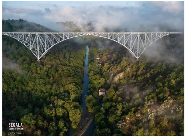
C'est une remarquable réalisation métallique de l'ingénieur **Paul Bodin** : des poutres d'acier, des arches, un million de rivets... Cette dentelle aérienne s'élève à 116m de haut sur 460m de long, avec un arc central de 220 m d'envergure.
